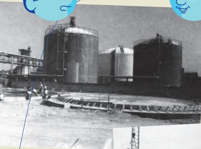
1989. Construction de deux réservoirs d'ADN supplémentaires de 2000 m<sup>3</sup>.
