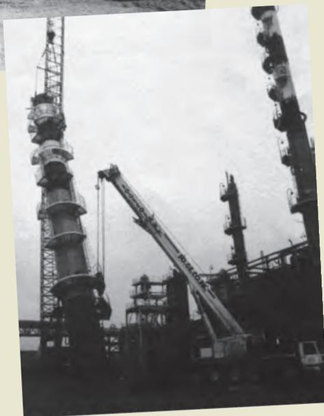
1990. Une nouvelle colonne de distillation est érigée à l'aide d'une grue de 400 tonnes.
