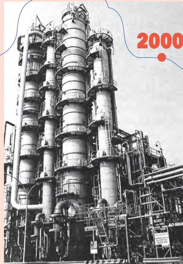
En 2000, **DAPHNE** installe un nouveau réacteur et modifie plusieurs colonnes à distiller pour accroître la capacité de production, fiabiliser les installations et garantir le niveau de qualité du produit.
